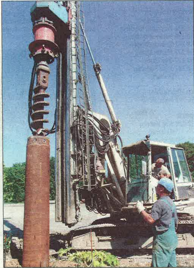
In den Boden am Bahnhof werden die Fundamente gerammt, auf denen die künftige Fachhochschule im Sommer nächsten Jahres stehen soll. ■ Foto: Nougrigat
